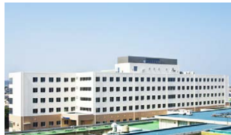
福岡東医療センター (福岡県古賀市・591床)
